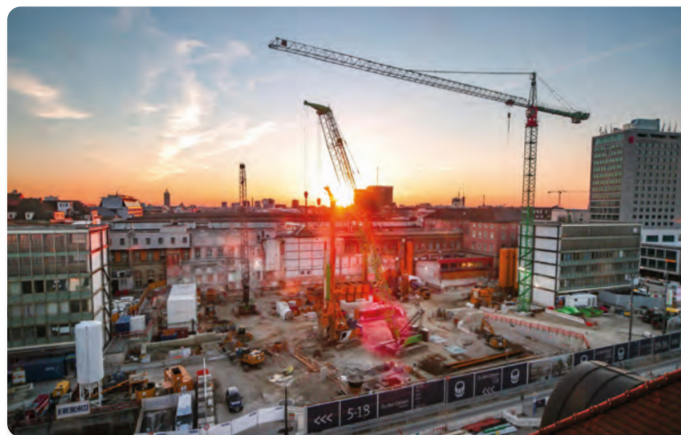
Vorbereitende Arbeiten zum Bau der 2. Stammstrecke - Situation am Hauptbahnhof im Jahr 2021
