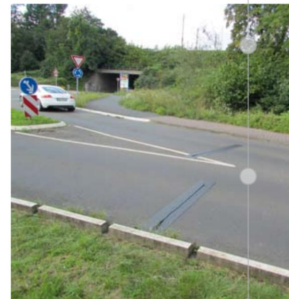
Abbildung 7: Auf der Zu- bzw. Abfahrt eines P+R-Platzes angebrachter eTube-Überfahrkontakt.
