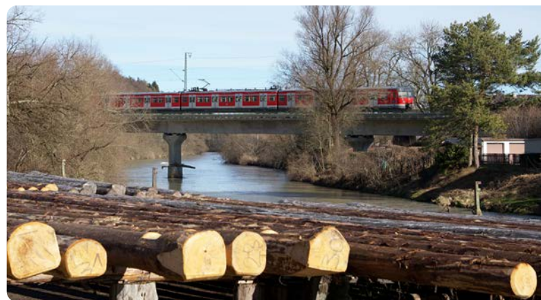
Eine S7 bei der Überquerung der Loisach in Wolfratshausen
